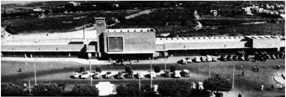
محطة قطار سيدي جابر
